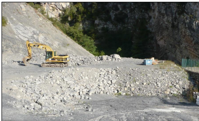
Zone tampon de stockage des blocs (Photo SEGED 13/10/2014)
