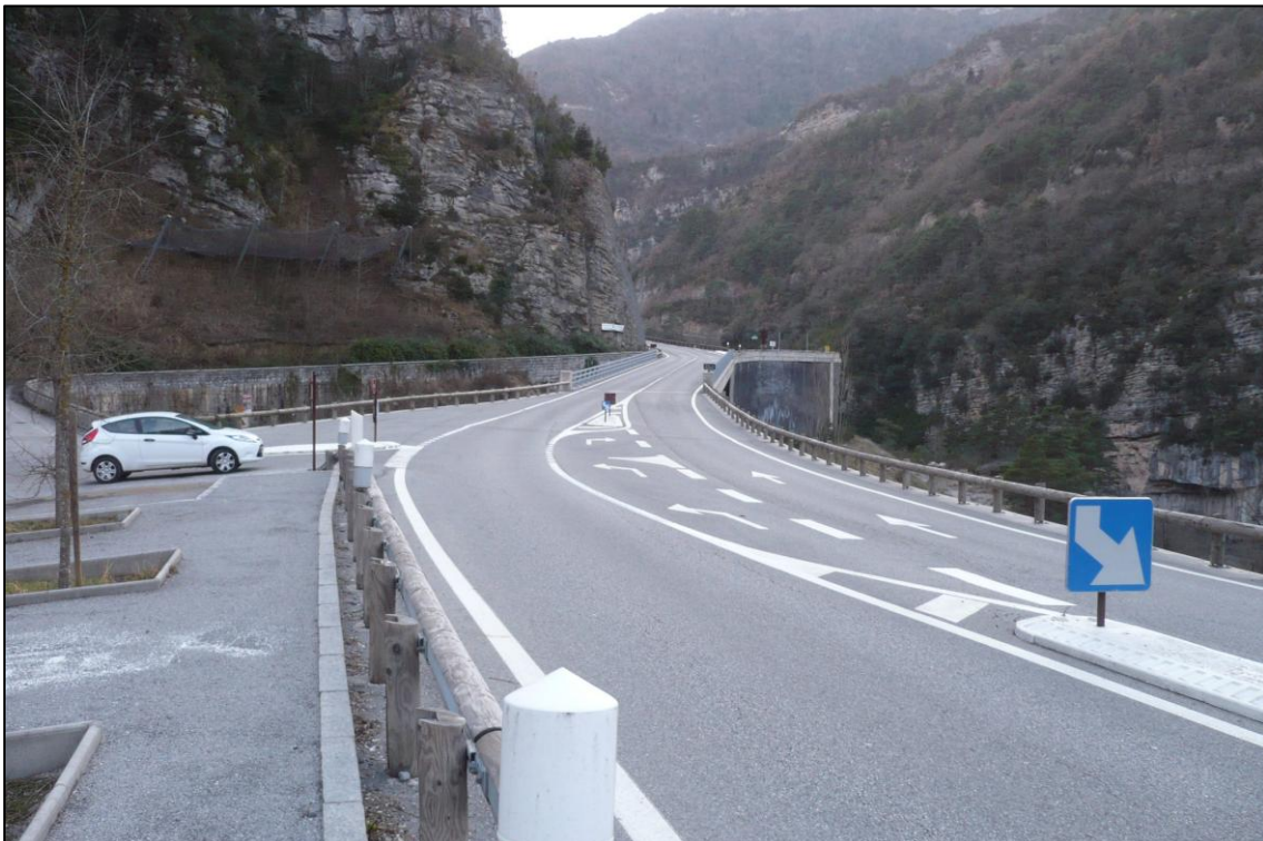
Aménagement de l'accès à l'installation
