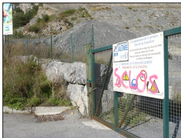
Entrée et clôture de l'installation (Photo SEGED 23/05/2014)
