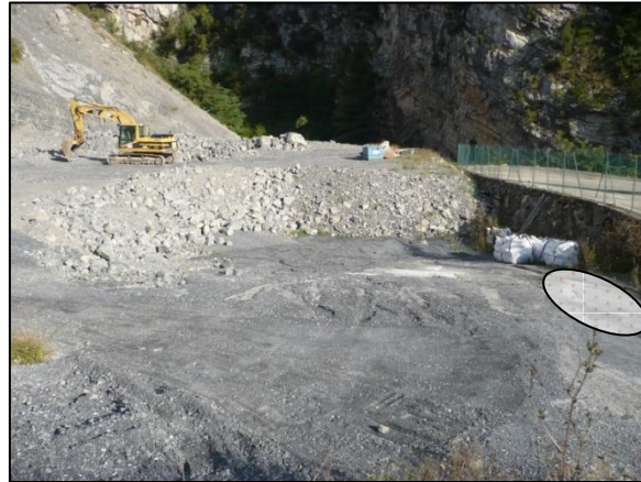
Emplacement projeté pour des installations sanitaires (Photo SEGED 23/05/2014)
